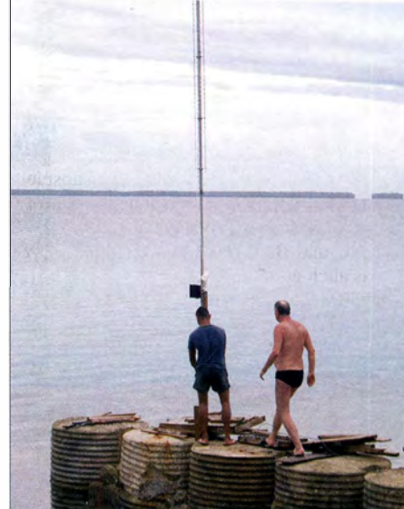
Aufbau der AV-620 auf einer Buhne in der Lagune
