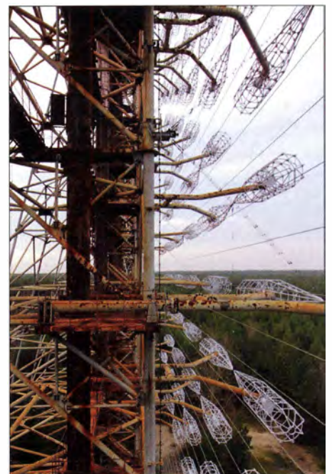
Bild 2: Das Antennenfeld ist heute zu besichtigen.
