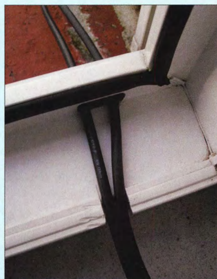
Bild 14: Durchführung durch das Rahmenprofil in der Innenansicht
