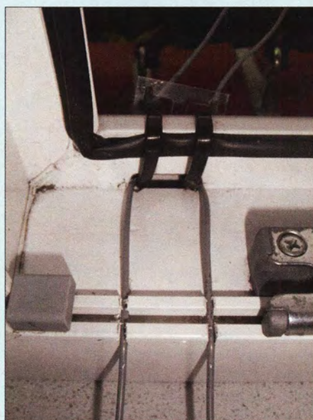
Bild 10: Detailansicht der Durchführung der Zweidrahtleitung durch den Belüftungsschlitz im Fensterrahmen
