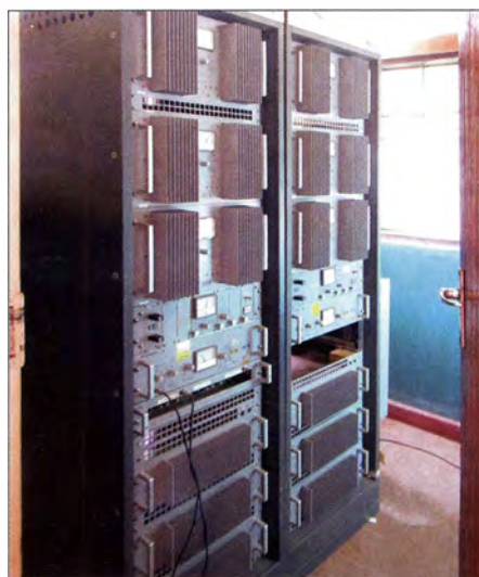
1,5-kW-Sender von Telefunken für 91 MHz
