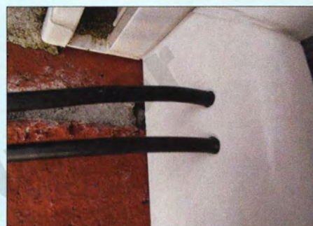
Bild 13: Einführung der Koaxialkabel in das äußere Fensterrahmenprofil
